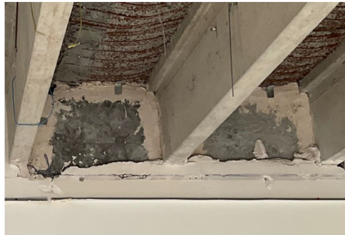
Photo rebouchage réalisé Bâtiment G
